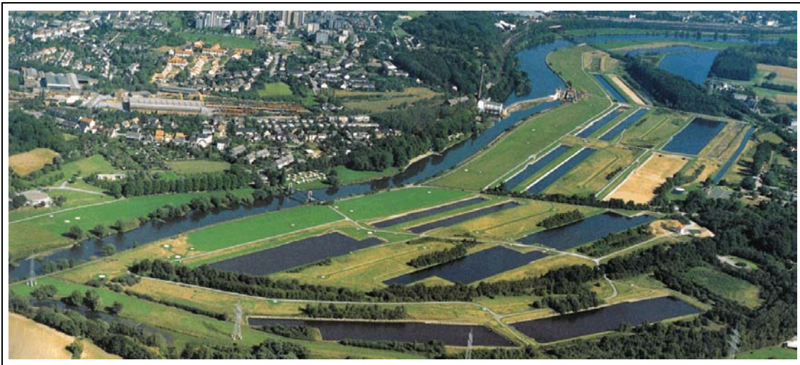
Abb. 2.2: Wassergewinnung im Ruhrtal in Essen-Steele (Quelle: RUHRVERBAND und RUHRTALSPERRENVEREIN 1998)
