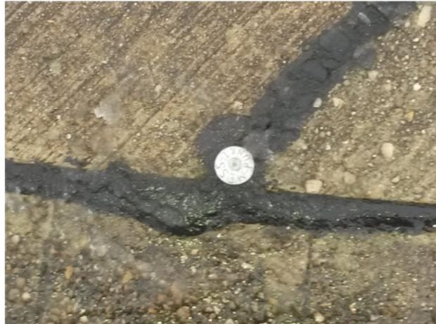
Abbildung 42: Vermarkte Festpunkte (Vermessungsnagel)
