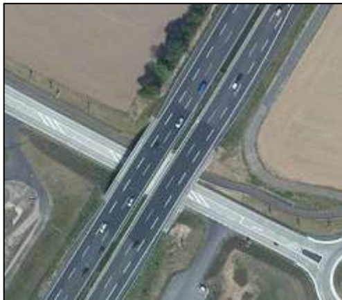
Abbildung 83 Objekt 326 Hauptstraße (Unterführung)
