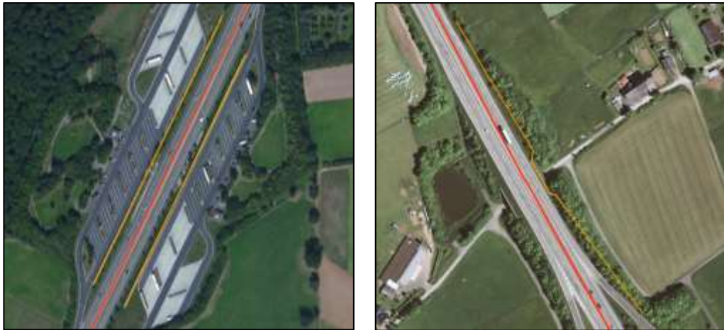
Abbildung 99 Beispiele Bauwerk 'Laermschutz': links Wand, rechts Wall
