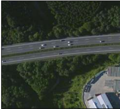
Abbildung 87 Objekt 341 Wirtschaftsweg (Unterführung)
