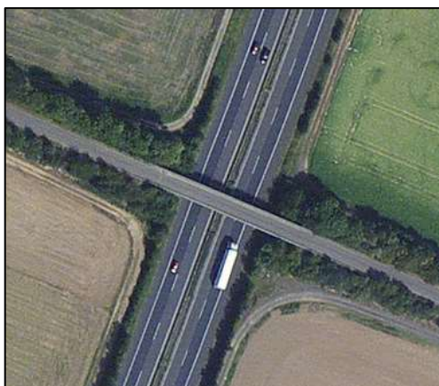
Abbildung 85 Objekt 321 Nebenstraße (Überführung)
