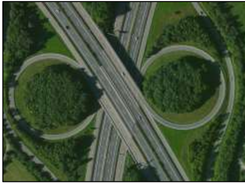
Abbildung 81 Objekt 380 Autobahn (Unterführung)
