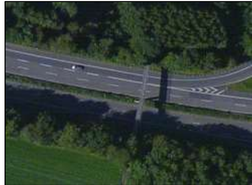
Abbildung 82 Objekt 368 Fußweg (Überführung)
