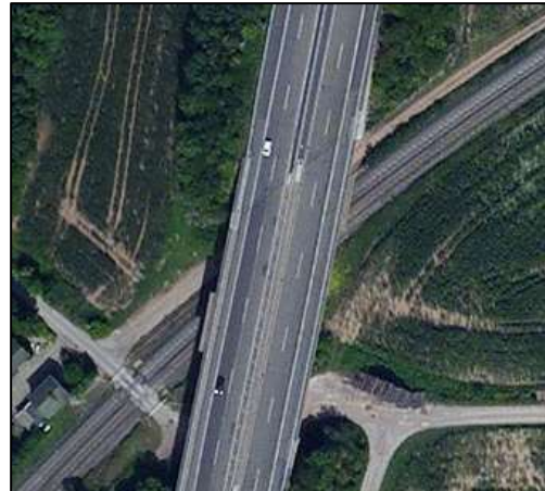
Abbildung 88 Objekt 311 Eisenbahn (Unterführung)
