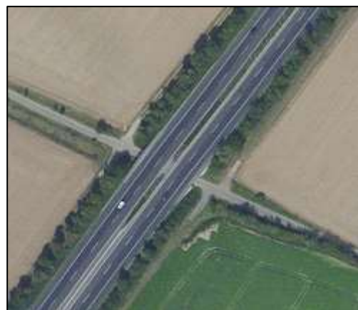
Abbildung 86 Objekt 324 Nebenstraße (Unterführung)
