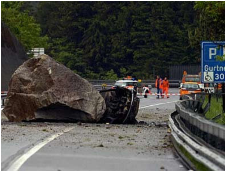
Abbildung 2: Steinschlag auf Gotthard-Autobahn (www.sueddeutsche.de)
