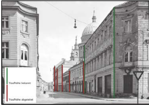
Abb. 5.6 Ermittlung der Traufhöhen in historischen Aufnahmen anhand einer bekannten Achsenlänge. (Quelle: Bundesbildarchiv)
