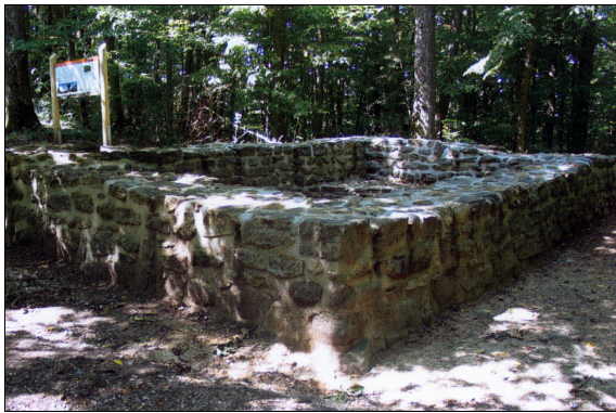
Abbildung 11: Restauriertes Fundament eines Wachturms (aus: Fischer et al. 2008, S.102)
