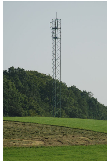
Abb. 3–2: Partielle Sichtbarkeit eines Stahlgittermastes
