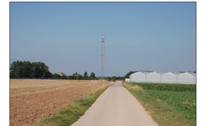
Sto.6: Wegekreuzung südlich des Standorts
