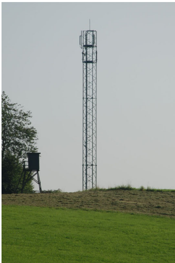
Abb. 3–1: Gesamtansicht eines Stahlgittermastes
