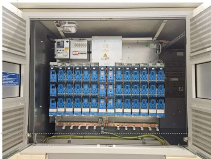
Abbildung 4: NH-Leiste mit Phasenanschluss in blau
