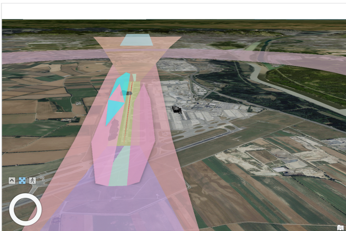
Abb. 3.12: Entfernung nicht benötigter OLS
