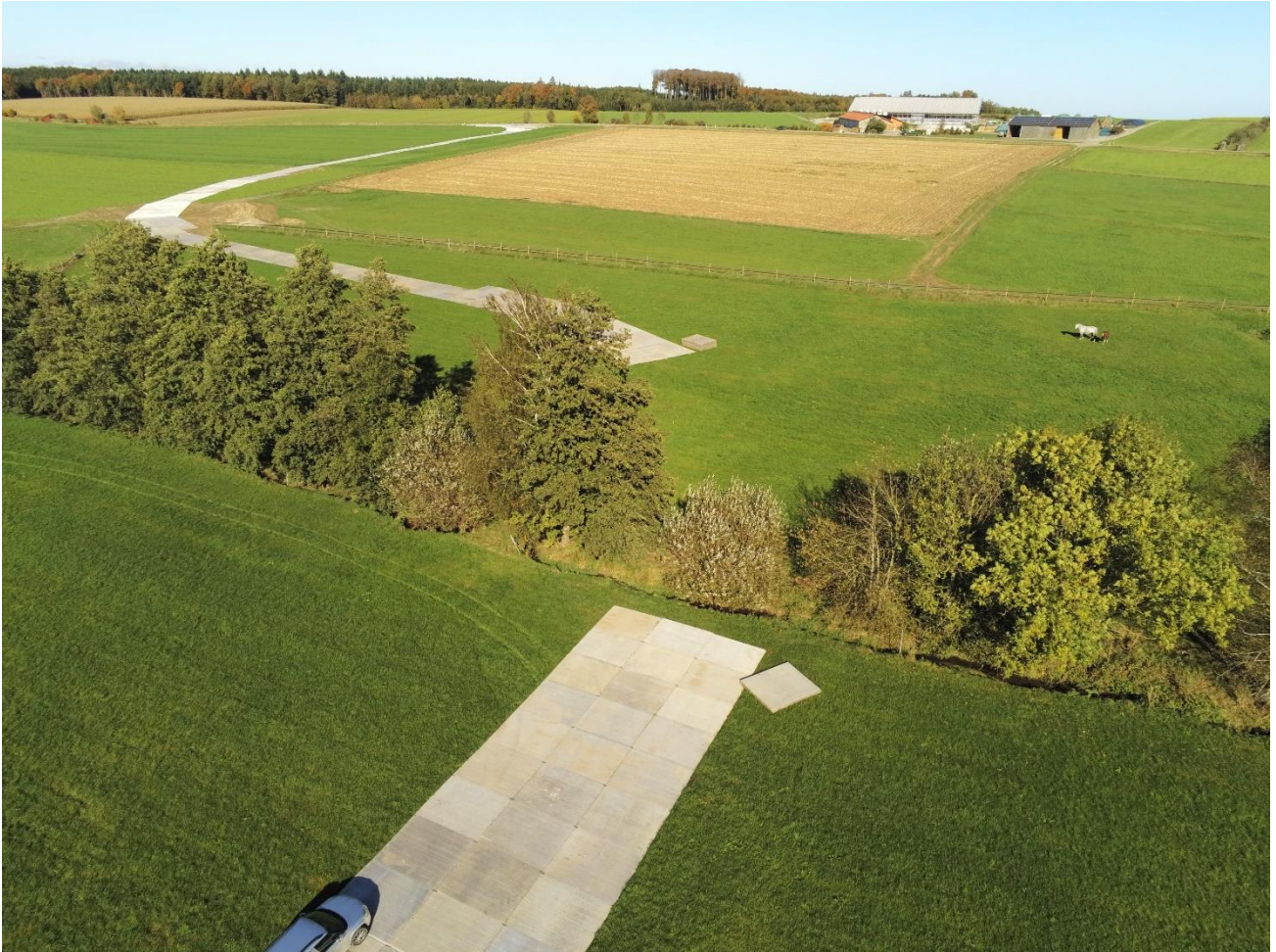
Abbildung 13: Eine Plattenstraße als temporäre Ortsumgehung im Bau. In der Bildmitte ist ein Bachlauf zu erkennen, der für die Überfahrt zeitweise mit einer Verrohrung eingefasst wurde (Quelle: eigene Aufnahme).
