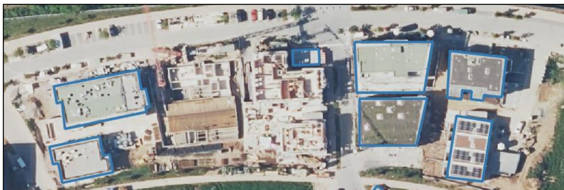
Abbildung 36 - Darstellung der manuell erfassten Gebäudeobjekte gemäß Bauerfassungskataster (blau) im Vergleich des noch im Bau befindlichen Objektes in der Bildmitte
