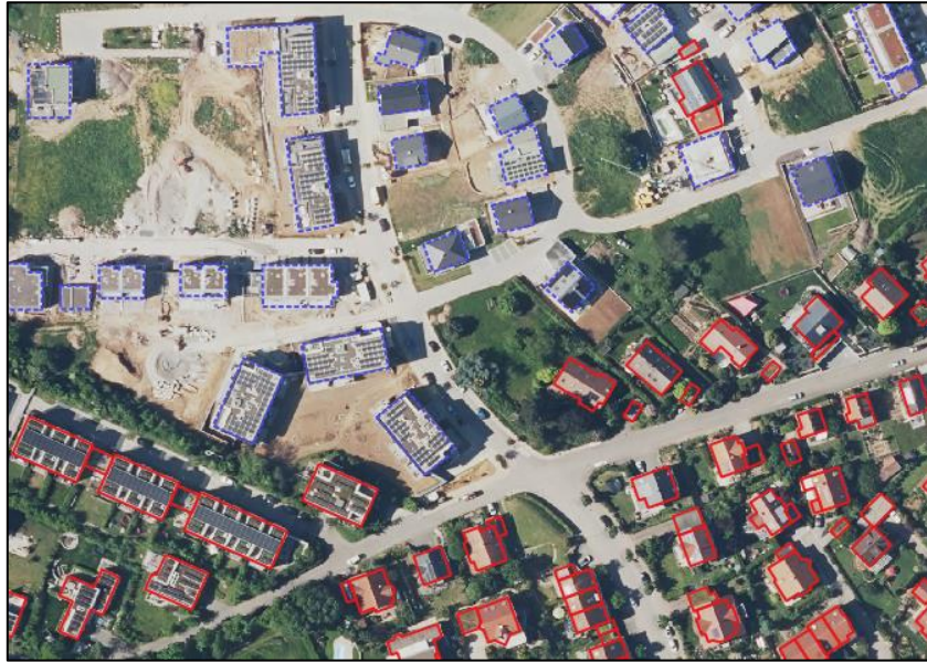
Abbildung 27 - Kombination der ALKIS-Daten (rote Umrandung) und der im Bau befindlichen Objekte (blaue Umrandung) in der DOP-Darstellung
