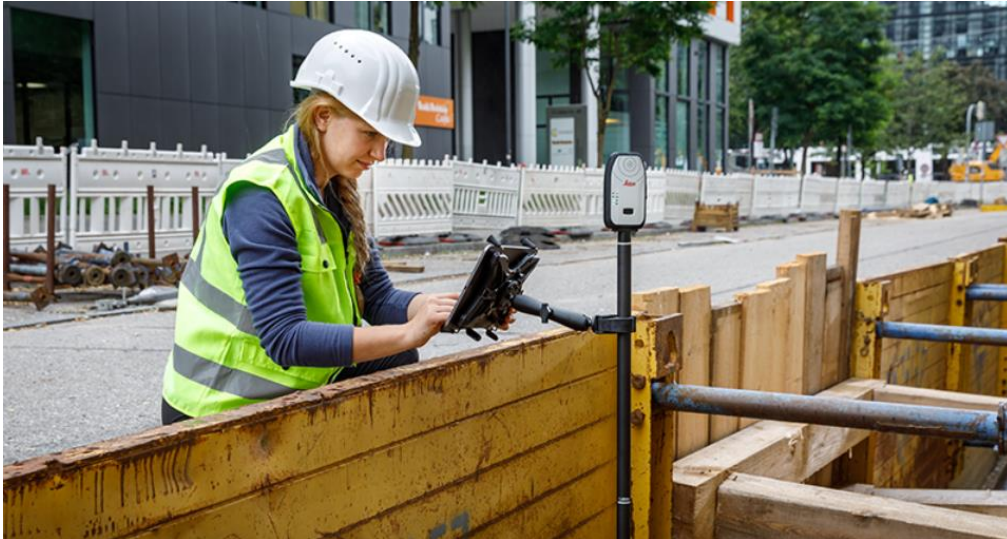
Abbildung 2-6: Darstellung des Leica Zeno FLX100 auf einer Baustelle 18
