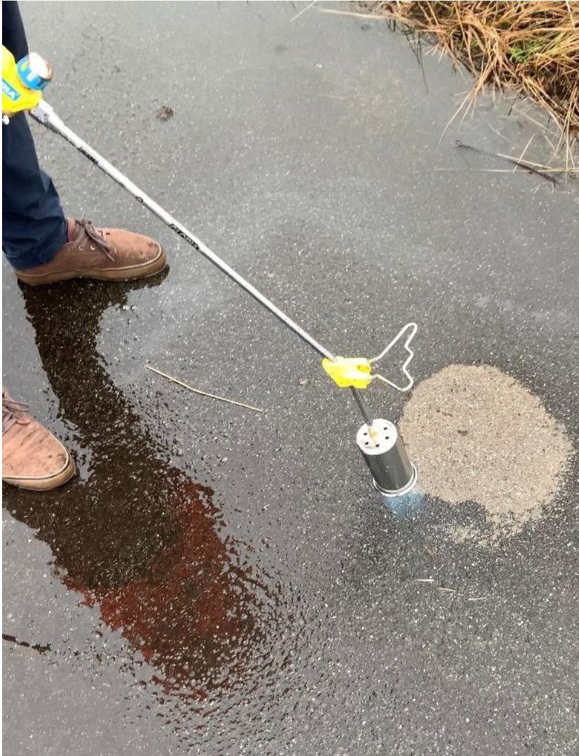
Abbildung 2-13: Trocknung der Fläche
