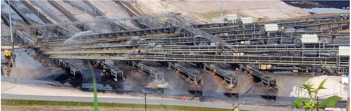
Abbildung 13: Bandsammelpunkt Tagebau Inden
