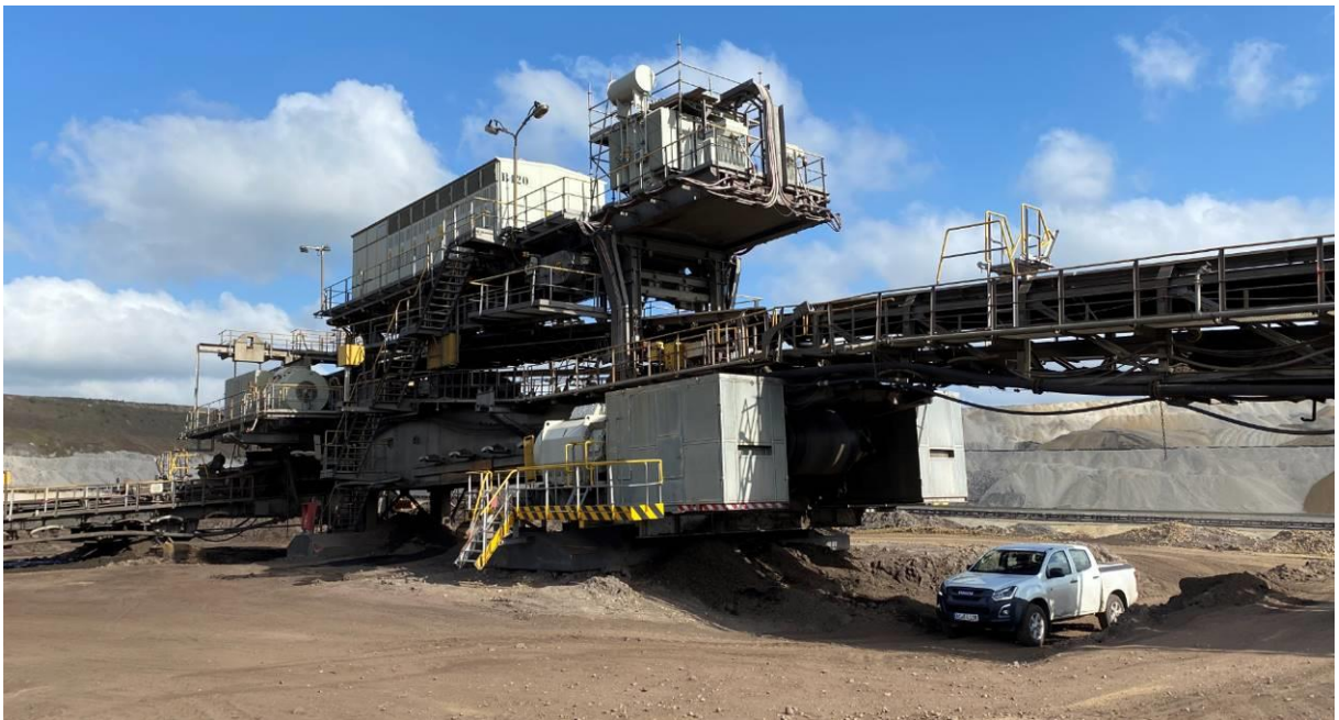
Abbildung 14: Antriebsstation einer Bandanlage
