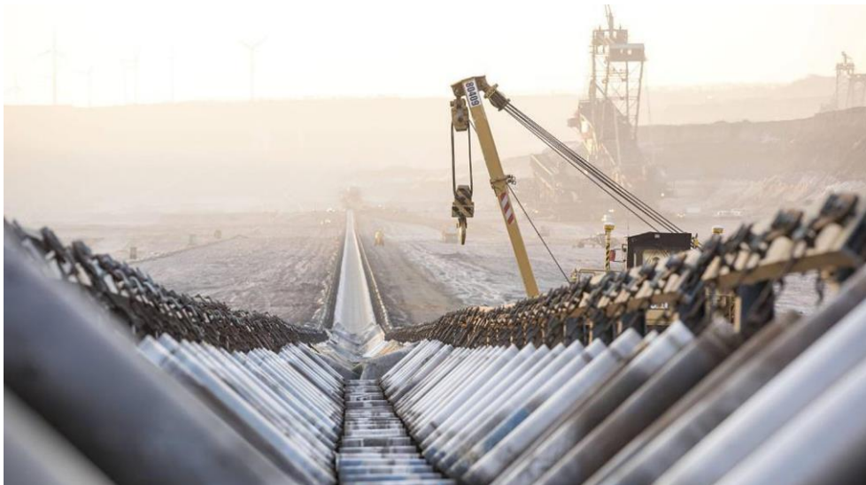
Abbildung 5: GNSS-gesteuerte Rückung einer Bandanlagen
