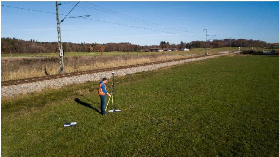
Abbildung31: Einmessen eines Checkpoints an der Bahnstrecke
