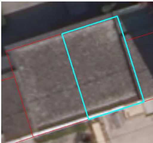
Abbildung 65: Dachfläche mit unterschiedlich eingeschätztem Kiesanteil, Aufnahme aus dem Jahr 2011 (2)
