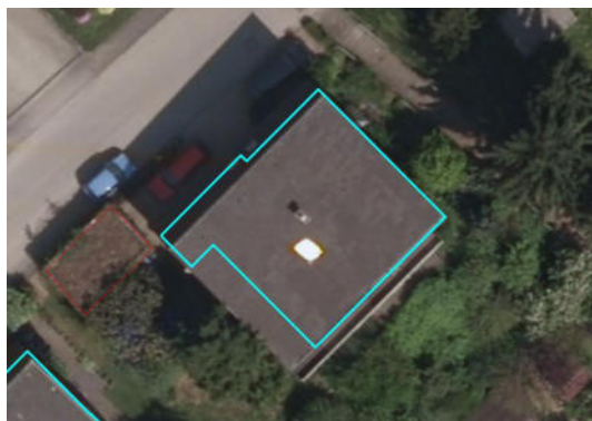
Abbildung 57: Dachfläche ohne Kiesbelag in der Aufnahme aus dem Jahr 2011
