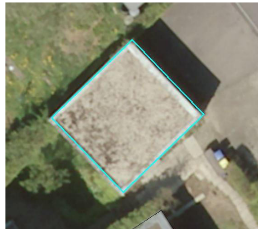
Abbildung 48: Dachfläche im Jahr 2016 nicht mehr begrünt (1)
