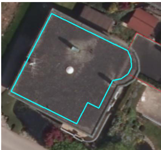
Abbildung 69: Dachfläche aus der Aufnahme aus dem Jahr 2011 (2)
