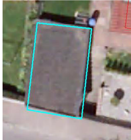
Abbildung 68: Dachfläche aus der Aufnahme aus dem Jahr 2016 (1)
