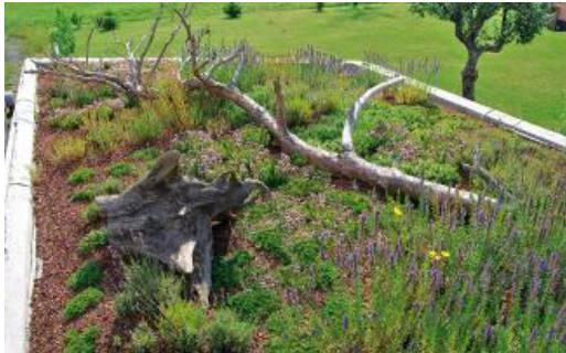
Abbildung 6: Totholz als Element eines Biodiversitätsdaches. Quelle: ZinCo GmbH, online: http://www.zinco.de/biodiversit%C3%A4t-auf-dem-dach (abgerufen am 12.05.2018).
