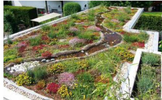
Abbildung 7: Wasserflächen als Element eines Biodiversitätsdaches. Quelle: ZinCo GmbH, online: http://www.zinco.de/biodiversit%C3%A4t-auf-dem-dach (abgerufen am 12.05.2018).
