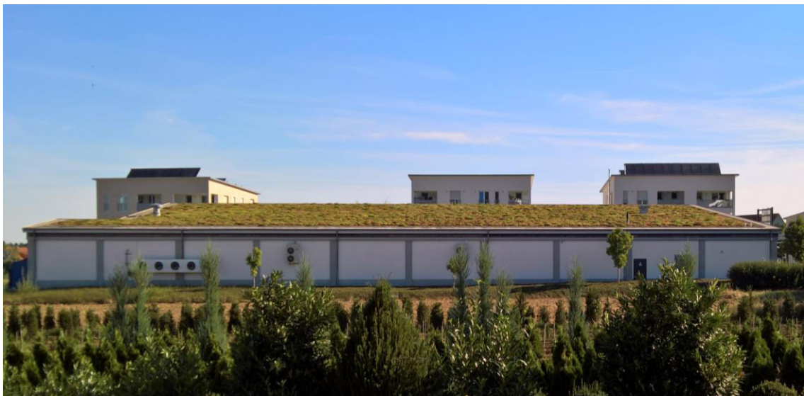
Abbildung 2: Extensive Dachbegrünung auf der Lidl-Filiale in Weilheim Teck (Foto: M. Röhrner)
