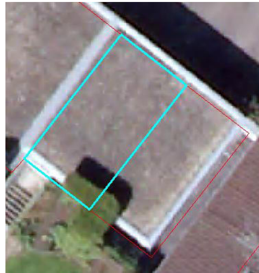
Abbildung 64: Dachfläche mit unterschiedlich eingeschätztem Kiesanteil, Aufnahme aus dem Jahr 2016 (1)
