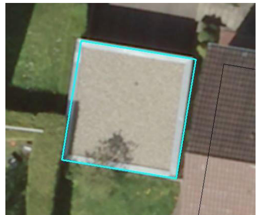
Abbildung 50: Dachfläche im Jahr 2016 nicht mehr begrünt (2)
