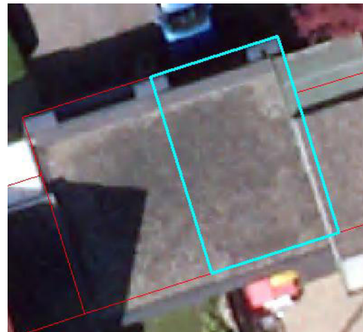
Abbildung 66: Dachfläche mit unterschiedlich eingeschätztem Kiesanteil, Aufnahme aus dem Jahr 2016 (2)
