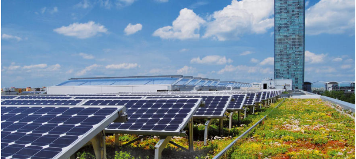
Abbildung 8: Gründach und Solar. Quelle: ZinCo GmbH, online: https://www.zinco.de/solar (abgerufen am 16.06.2018)
