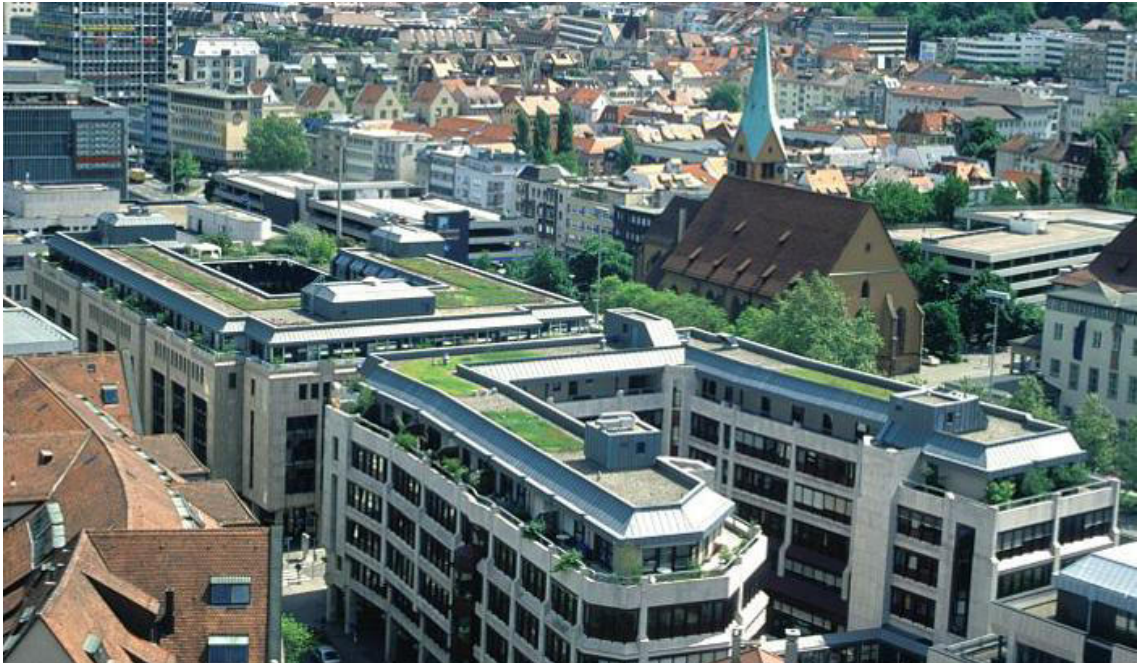
Abbildung 4: Durch Dachbegrünung aufgelockertes Stadtbild, Quelle: https://www.staedtebauliche-klimafibel.de/sh2.php?f=abb-6-5b.jpg (abgerufen am 16.06.2018)
