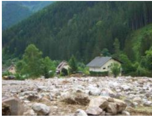
Abbildung 21 Ablagerungen und beschädigte Gebäude am Schwemmkegel Weinkellerbach
