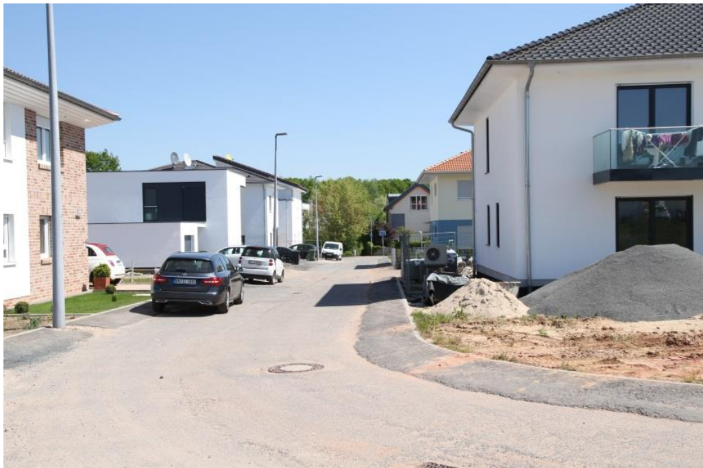
Abbildung 29: Aktuelle Aufnahmen aus dem Baugebiets 70 (Mai 2016)
