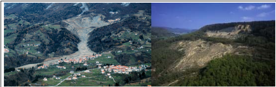
Abbildung 1: Naturgefahr Hangrutschungen in Europa: In den Dolomiten bei Corvara in Badia, Italien (links) und an der Schwäbischen Alb bei Mössingen, Deutschland (rechts).
