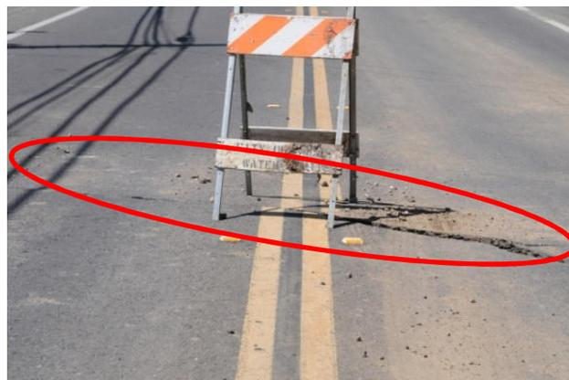
Abbildung 3: laterale Verschiebung durch das Napa Erdbeben vom 24.08.2014 (Quelle: usgs.gov<sup>8</sup>)
