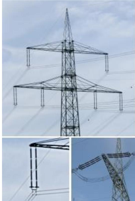
Abb. 48: Aufhängepunkte an Tragmasten (oben und links) und Abspannmastern (Quelle: Wikipedia (2003))
